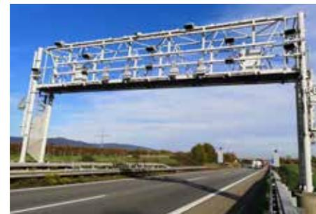
As pontes de controlo e as colunas de controlo são dispositivos estacionários que, no fluxo de tráfego, à passagem de um veículo, controlam se o mesmo está sujeito ao pagamento de portagens e se os dados do veículo relevantes para a portagem foram declarados corretamente. Quando um veículo passa, é obtida uma imagem superior, uma lateral e uma da chapa de matrícula.
